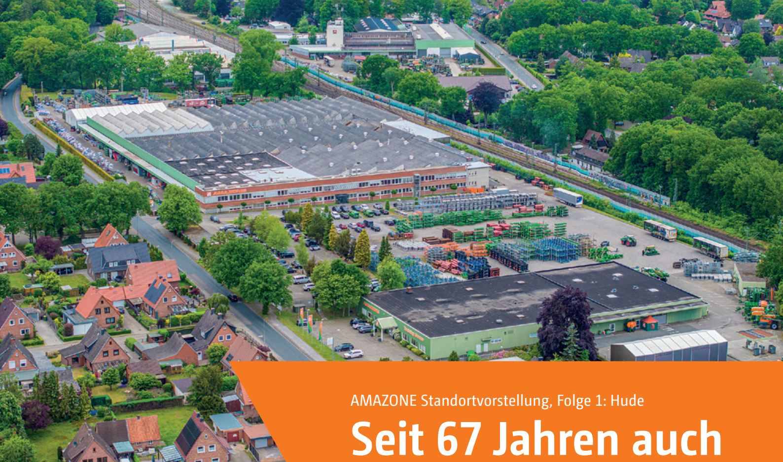
Luftansicht der ersten und größten AMAZONE Tochter in Hude bei Oldenburg
